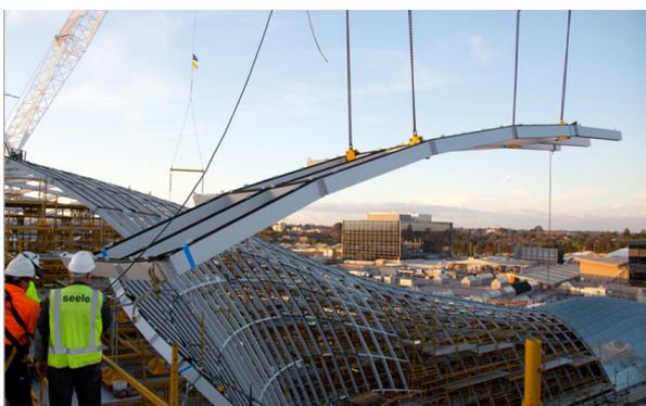
Der von seele pilsen vorgefertigte Präzisions-Stahlbau wurde Millimeter genau auf der Baustelle des Chadstone Shopping Centers eingepasst. © seele
