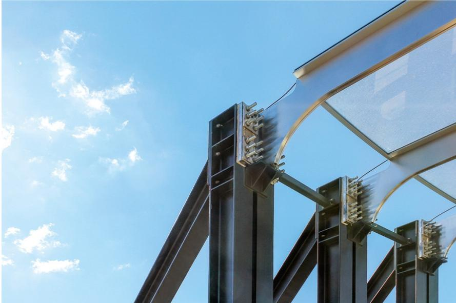
seele errichtete im Sommer 2016 ein Visual-Mock-up für das Projekt Gateway Arch. Die gefrästen Edelstahl-Vollprofile von seele pilsen bilden die Tragstruktur für die insgesamt 74 3-fach laminierten Dachgläser. ©seele
