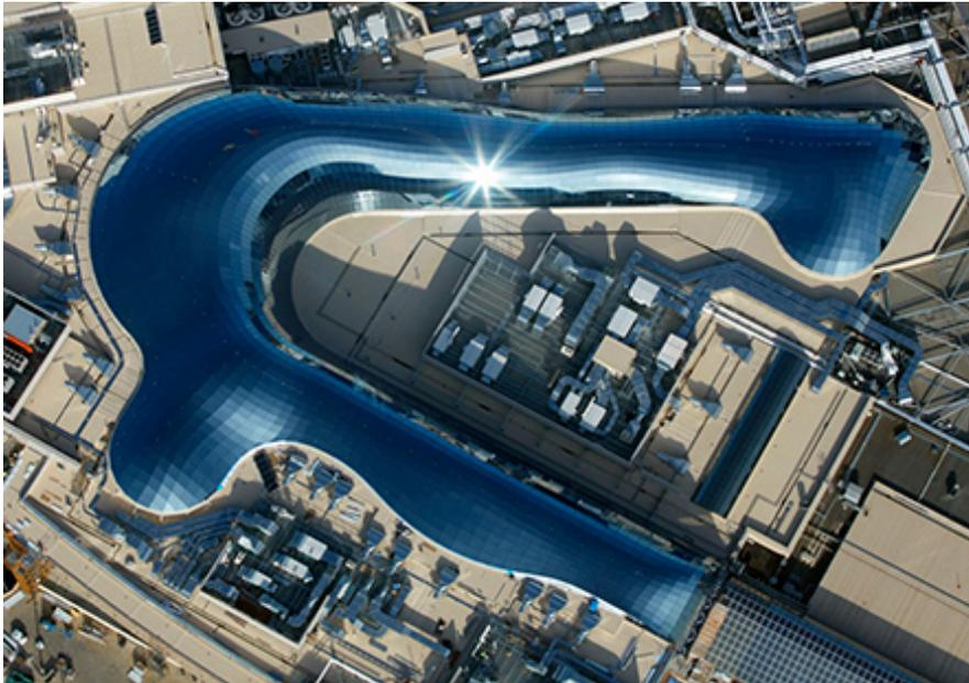
Für das Chadstone Einkaufscenter in Melbourne realisierte seele eine außergewöhnliche Stahl-Glas-Überdachung mit einer Gesamtfläche von 7.080qm. ©seele
