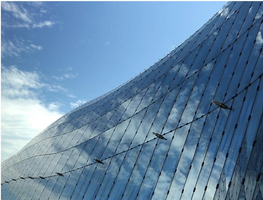
In nicht einmal sechs Monaten wurden 2.810 Stahlknoten, 5.168 Stäbe aus vier unterschiedlichen geschweißten Profiltypen gefertigt und 54 zweidimensional gebogene Randträger mit einer Länge von über 10m produziert und nach Australien geliefert. ©seele
