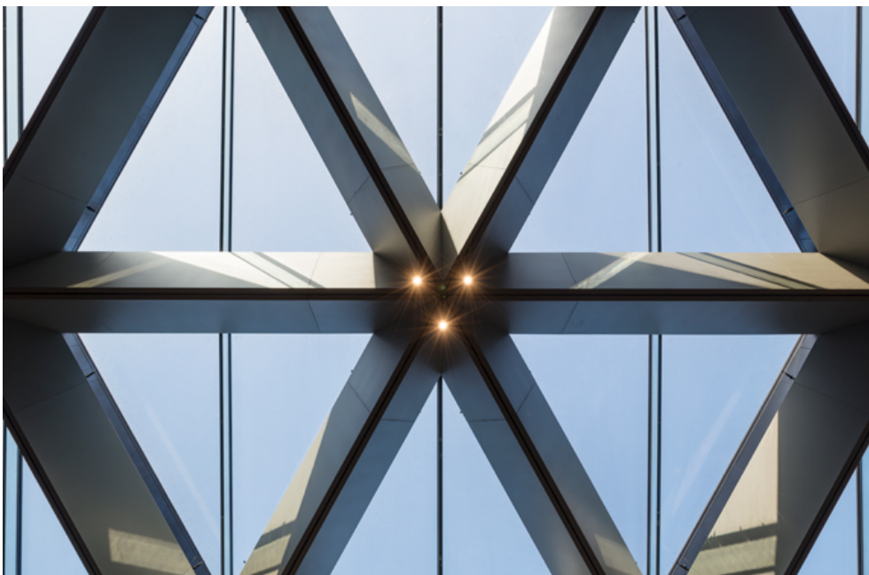
Multifunktionale Dachkonstruktion mit überwiegend dreieckigen Isolierglasfeldern ©James Newton
