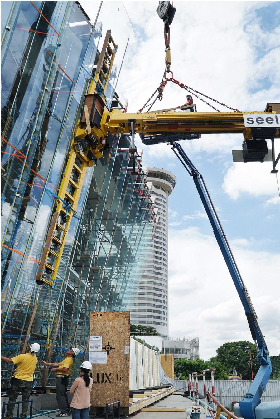
Montage der Glaspaneele: Die speziell angefertigte Sauganlage dreht das Glas in die geforderte Geometrie zum Einbau in die Fassade ein. © seele
