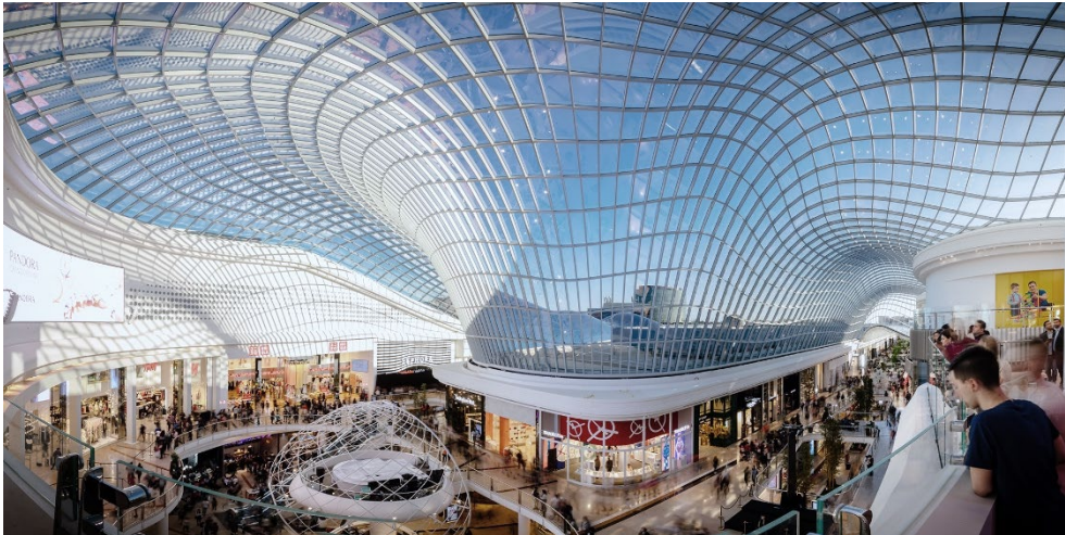
Eines der Highlights von se-austria: Die Realisierung des Chadstone Shopping Center in Melbourne als Freiform-Schalentragwerk mit 44m Spannweite © Vicinity Centers
