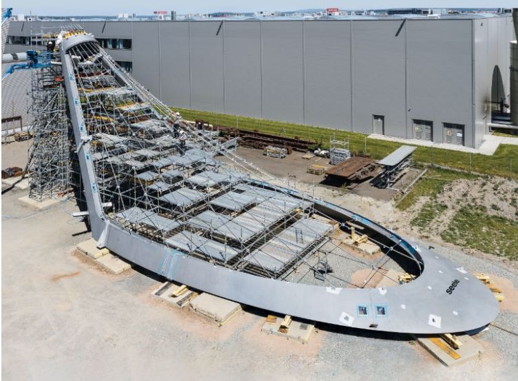
Die Stahlkonstruktion der 33rd Street Penn Station wurde zunächst in Pilsen/Tschechien aufgebaut und getestet und im Anschluss nach New York verschifft. © seele / GONO / Petr Nový
