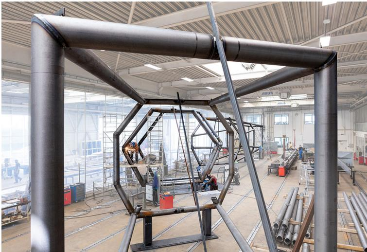
BU: Die formgebende Stahlkonstruktion der Capricorn Brücke. ©HG Esch
