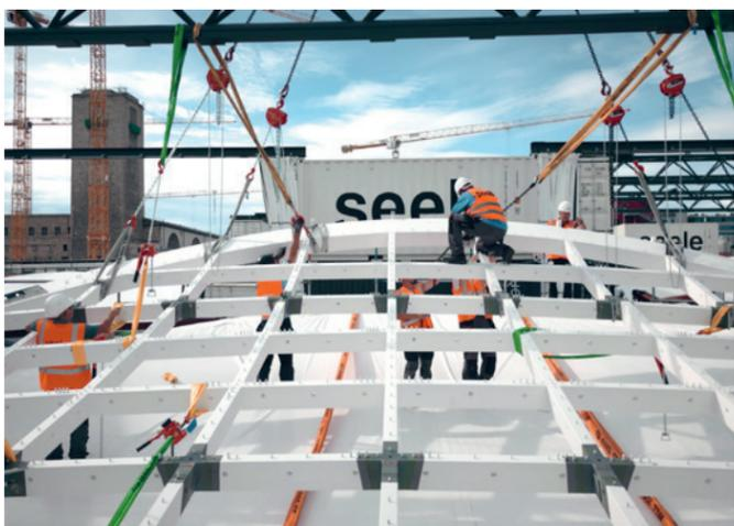
4\_ Das Montageteam arbeitet auf einem Sicherheitsnetz, das über die 21m große Öffnung des Lichtauges gespannt ist.
