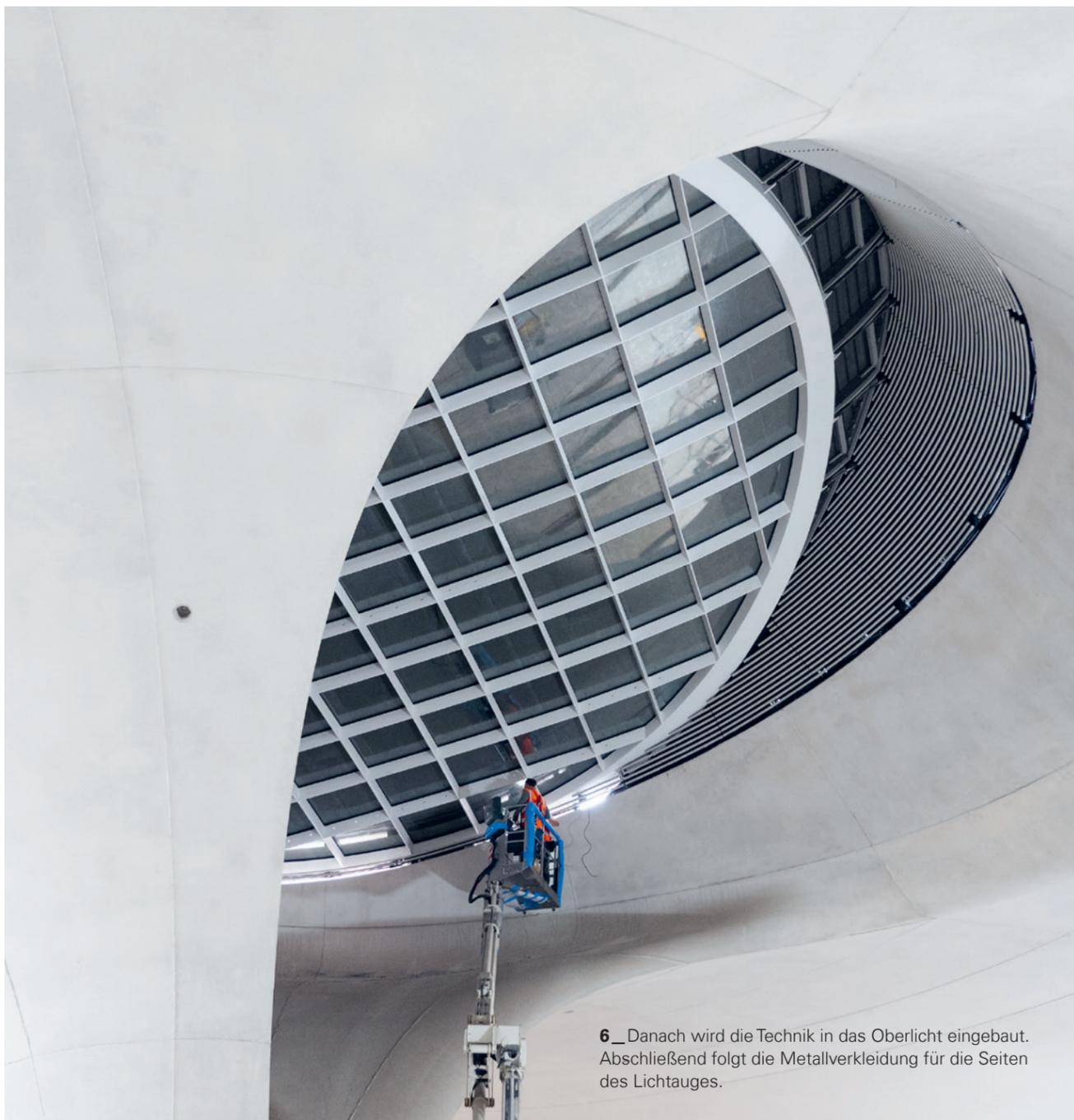
6\_ Danach wird die Technik in das Oberlicht eingebaut. Abschließend folgt die Metallverkleidung für die Seiten des Lichtauges.
