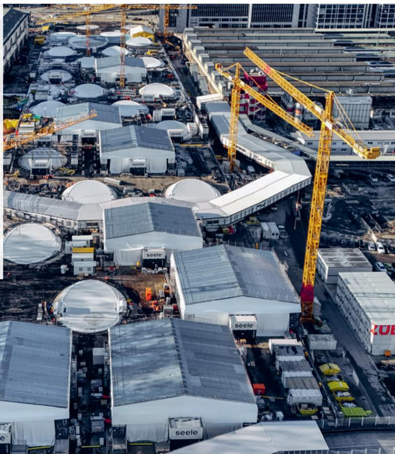
Dort, wo **seele** gerade ein Lichtauge montiert, wird vorher ein Zelt als temporäre Montagehalle errichtet. Die Vielzahl an Einhausungen bedeutet, dass **seele** an mehreren Oberlichtern gleichzeitig arbeitet, die sich alle in einem anderen Baufortschritt befinden.
