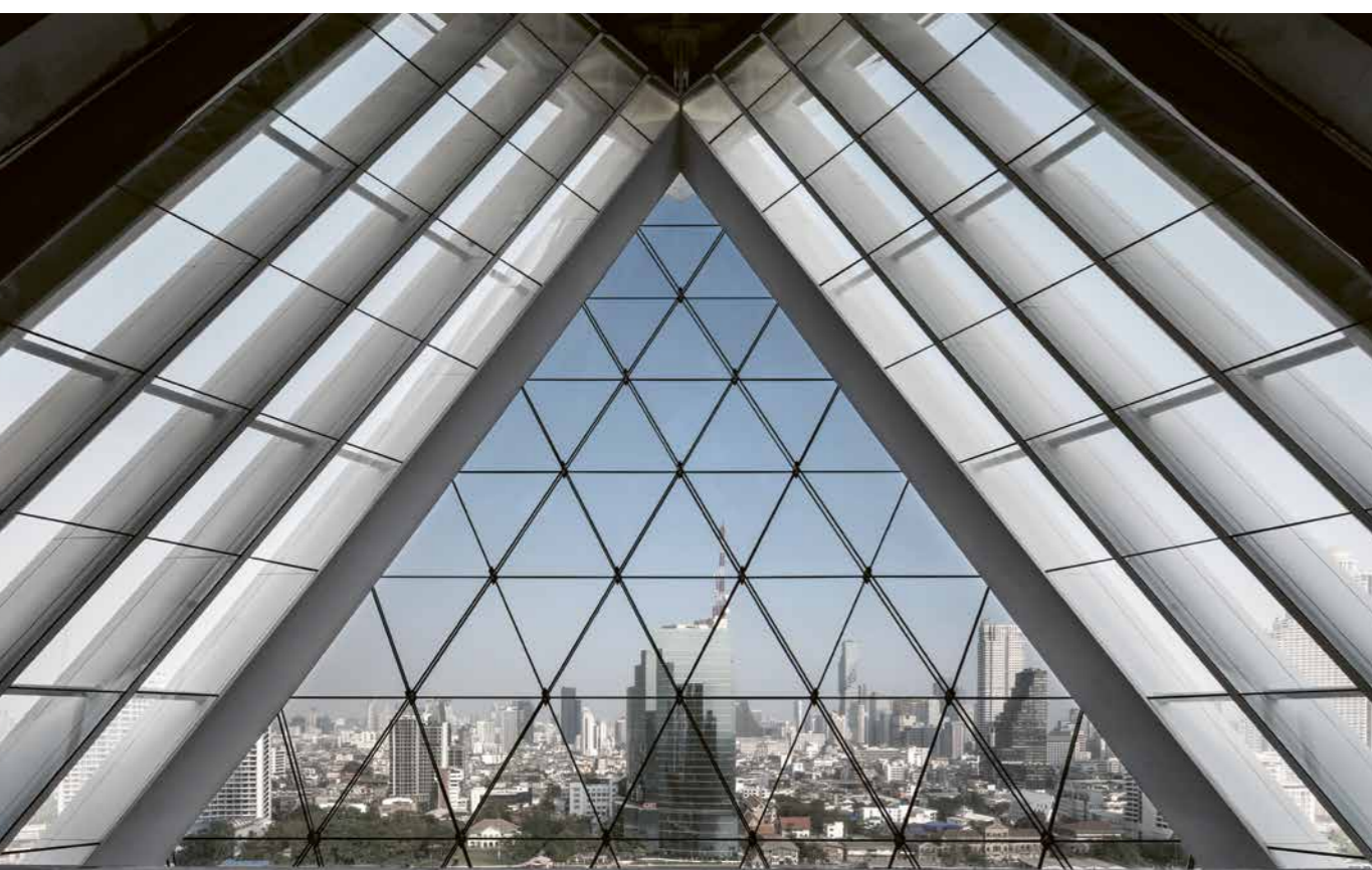
ICONSIAM Wisdom Hall, Bangkok/Thailand Die Seilnetzfassade aus 64 dreieckigen Gläsern, 14 diagonal vorgespannten Stahlseilen und 21 Seilknoten bildet den höchsten Punkt des ICONSIAM Einkaufszentrums in Bangkok.
