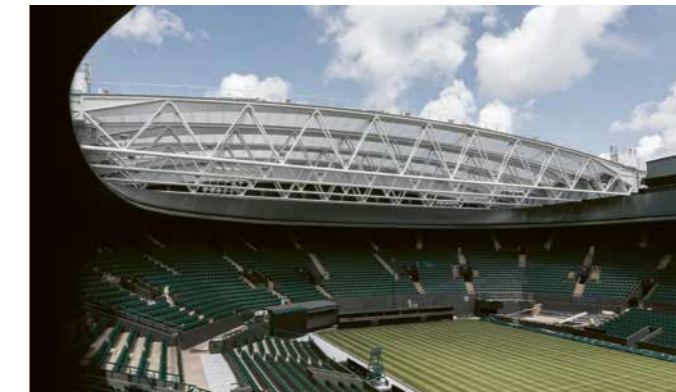
Wimbledon No.1 Court, London/UK → Umfassende Materialkompetenz aus einer Hand: Für das berühmte Tennis-Stadion realisierte seele ein verfahrbares Membrandach sowie komplexe Fassadenkonstruktionen.
