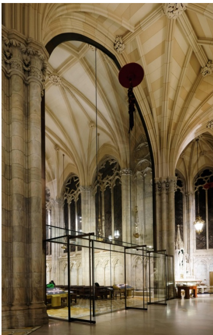
7m Glasträger aus 8-fach Laminat, der die 10,7 x 2,4m großen Fassadenscheiben stützt. ©Stephan Wurster
