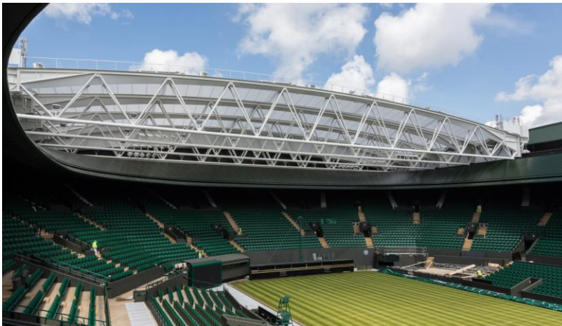
6.000qm großes und verfahrbares Membrandach für den Wimbledoncourt © seele
