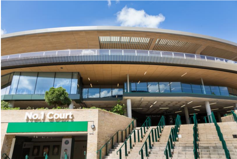
Der generalsanierte No.1 Court des Wimbledonkomplexes mit 13 verschiedenen Fassadentypen und einem verfahraren Membrandach von seele © seele
