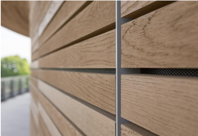
Die WPC-Lamellen und eine Lochblech-Unterkonstruktion bilden das Fassadenpaneel © seele
