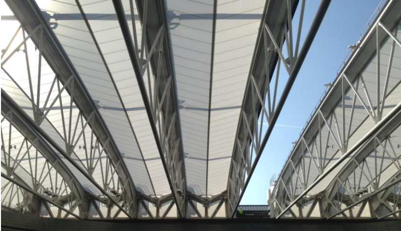
Membrankonstruktion im fast geschlossenen Zustand © seele
