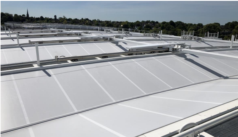
Die Membrankonstruktion besteht aus 10 jeweils 500qm großen PTFE-Flächen von seele © seele
