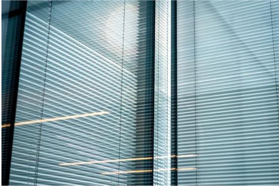
Die Verschattungsanlage im Zwischenraum von ISOshade® gewährleistet zuverlässigen Sonnen- und Blendschutz. © seele
